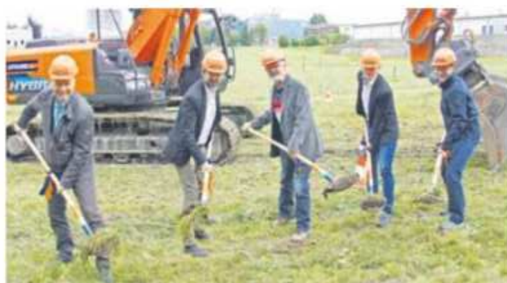
Freude über den Baustart zeigen Peter Schuppli, Philipp Kutter, Heini Hauser, Kurt Furrer (Leiter Tiefbau Lötscher AG) sowie Martin Schwendimann (Geozug Ingenieure).
